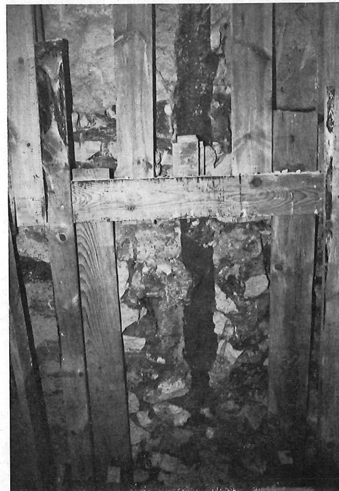
Fig. 15 et 16. — Contrôle par puits tangents au forage de l'effet d'une injection dans une carrière de calcaire effondrée.
