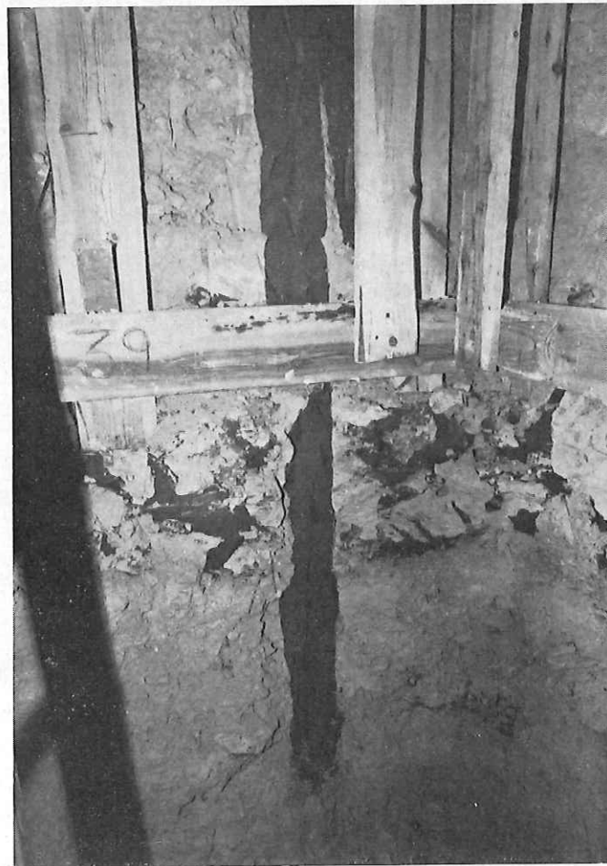
Fig. 15 et 16. — Contrôle par puits tangents au forage de l'effet d'une injection dans une carrière de calcaire effondrée.
