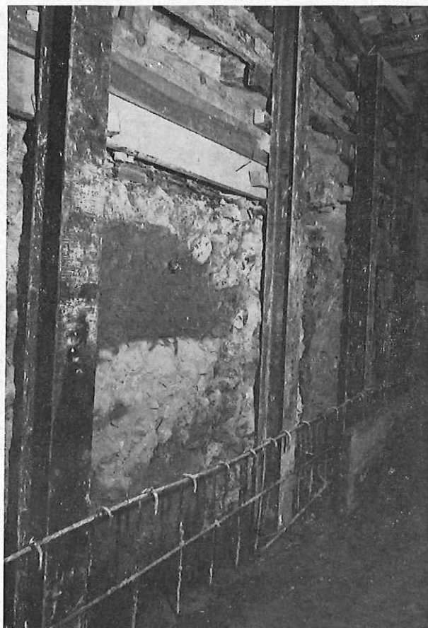
Fig. 9. — Coupure totale d'un ciel de carrière en galerie.
