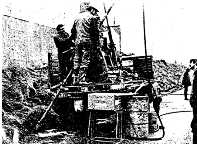
Fig. 17 : Barsac - Ligne S.N.C.F. Bordeaux-Sète - Forage d'injection.
