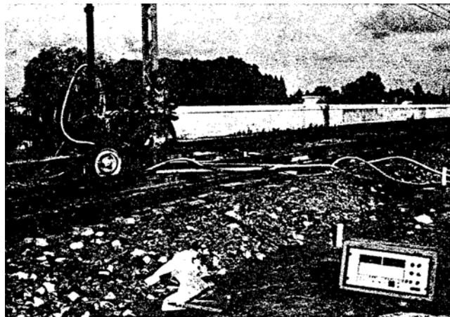
Fig. 6 : Foreuse avec enregistreur de paramètres - Déblai de Milly-la-Martine.
